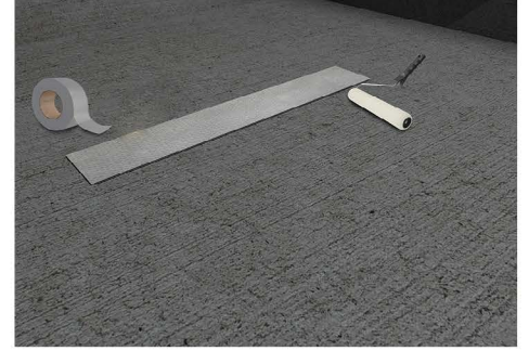
PH PRODRAIN Duş kanalı zemin izolasyonu / Apply waterproofing
