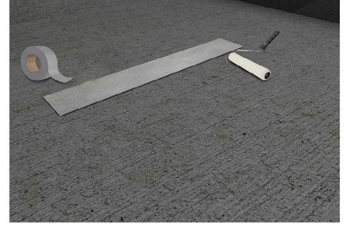
PH ART FLOW Duş kanalı zemin izolasyonu / Apply waterproofing
