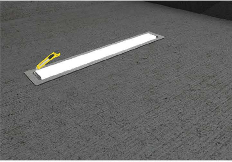
PH ART FLOW Duş kanalı zemin izolasyonu / Apply waterproofing
